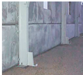
Sarg med betongsockel som enkelt monteras mot stålstommen.
