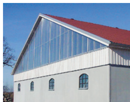
Oisolerat ridhus med stort ljusinsläpp på gavlarna.
