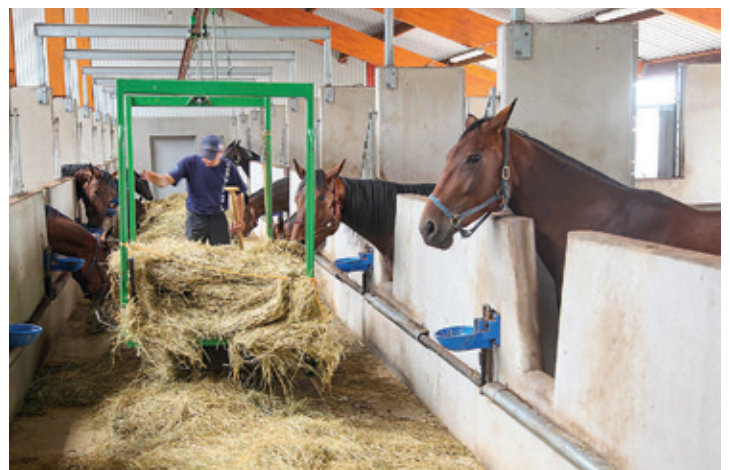
Foderbord med ätfronter i betong. Rundad kant i ättöppningen.
