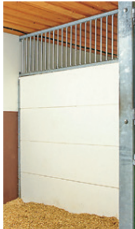
Stapelbara betongplank underlättar montage i befintliga stall.
