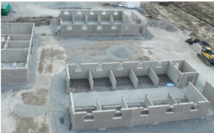
Vi har utformat och byggt stallbacken på Bro Park i Upplands Bro.
