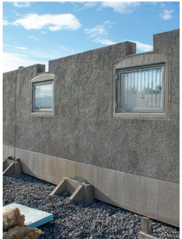
De prefabricerade betongelementen monteras enkelt på plats i fundamenten.
