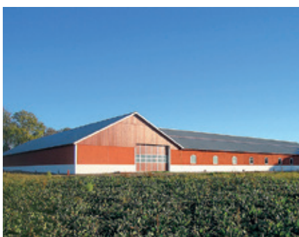
Oisolerat ridhus kombinerat med maskinhall.
