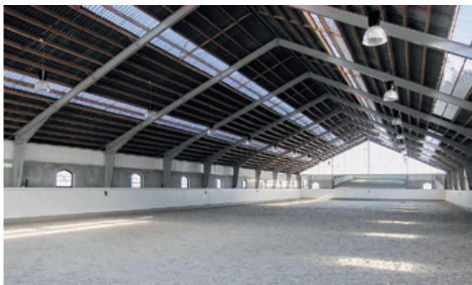
Interiör, oisolerat ridhus.
