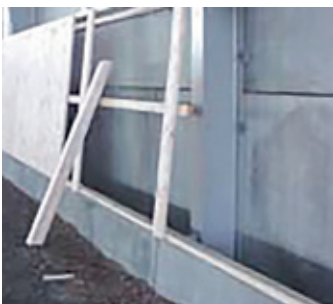
Betongvägg mot stålstomme med konsol för sarg.
