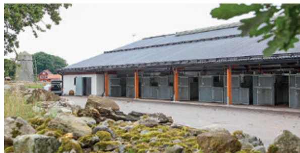
Isolerat stall med uteboxar. Enbart isolerad servicedel.
