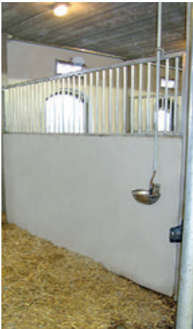
Halvhög betongmellanvägg med galler.
